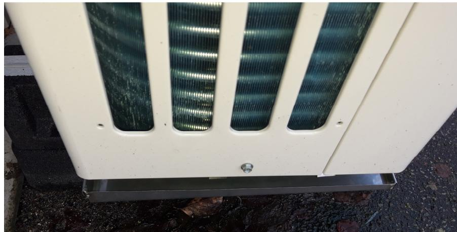
Ved hjælp af de 4 fjeder-tråde fastgøres kondensbakken til de to fødder under udedelen. Tråden stikkes under den ombukkede kant, føres hen over foden, og stikkes op under den ombukkede kant på den anden side af foden.
